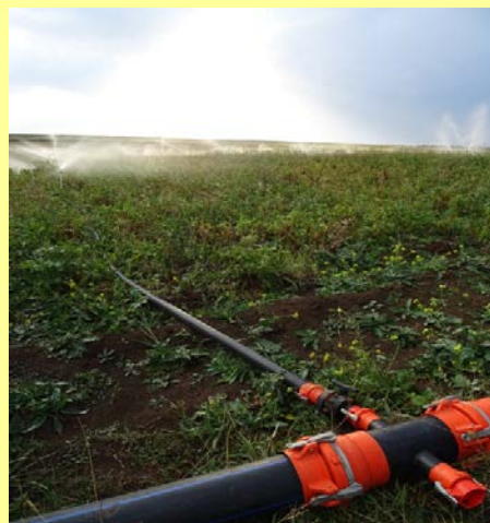
供与された移動式パイプとスプリンクラー
